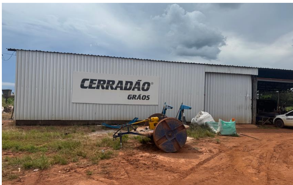
Figura 8. Estrutura de Armazenagem da Indústria de Rações
