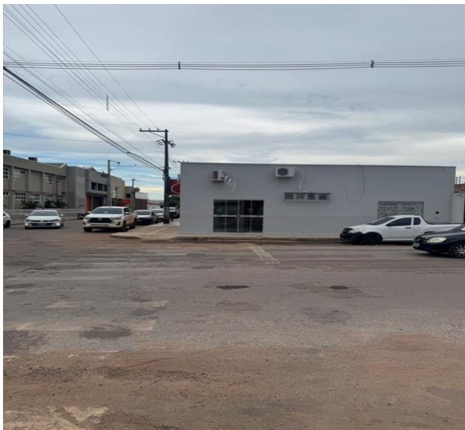
Figura 19. Fachada em Processo de Reformulação da Unidade Matriz
